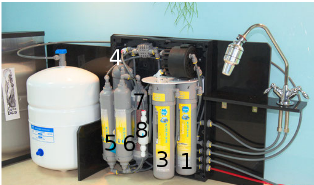
Bild: Anlage geöffnet. 12 Liter Tank daneben. Anlage montiert auf schwarzem Plexiglas. Im Vordergrund am Hahn: Aquadea Trintiy Silber Wirbelgerät mit drei Kristall-Wirbel-Kammern. Filterstufe Nr2 ist verdeckt, befindet sich hinter Nr1 und 3
